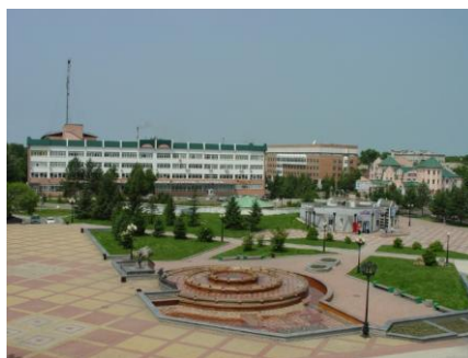
Здание управления федеральной почтовой связи Еврейской автономной области. 2011 г. ГАЕАО. Ф. Р-505. Оп. 1. Д. 2396.
