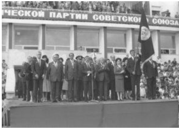
На стадионе «Строитель» 1984 год
