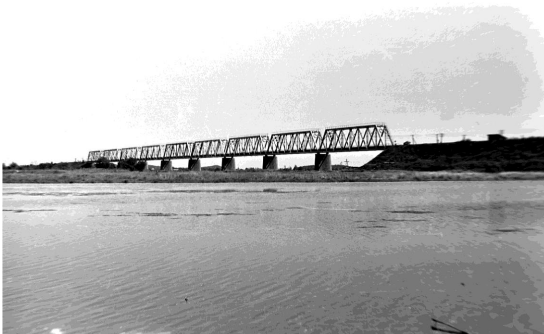
Мост через Тунгуску. Август 1973 года. Фотография из архива А. Кулиша.
