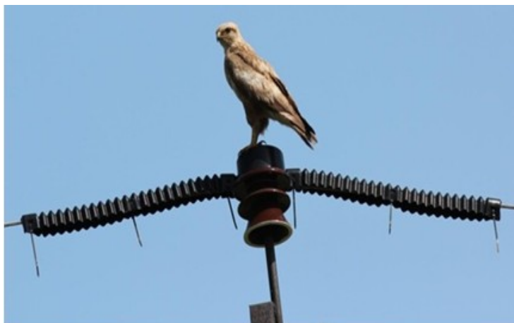
Рис. 2. Птицезащитные устройства контактного типа
