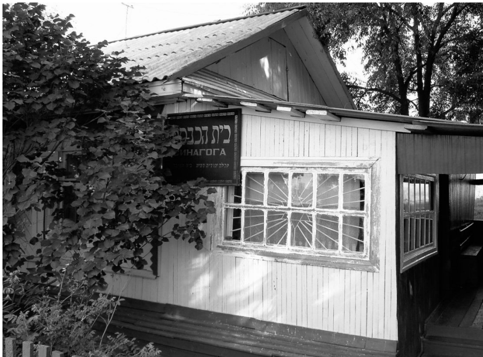
Рис. 8. Вход в здание синагоги общины «Бэйт-Тшува». Фото автора. 2005 г.
