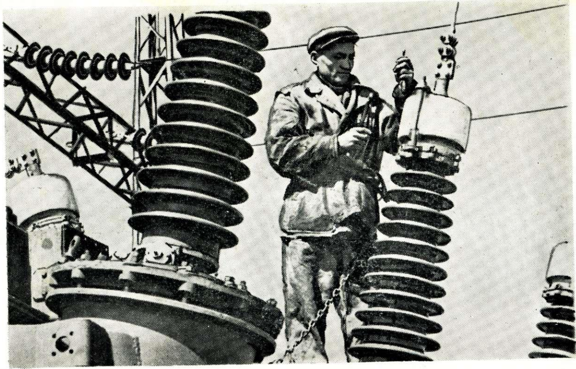
Монтаж подстанции ЛЭП в г. Биробиджане.
