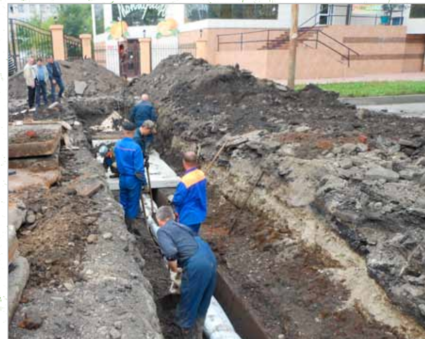
Работы ведет МУП «Городские тепловые сети»
