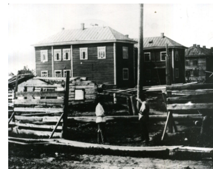
Строительство Биробиджана. Улица Ленина. 1935 г.
