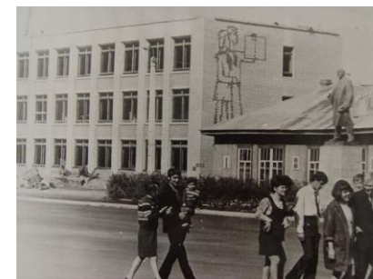
Строительство средней школы в с. Амурзет Октябрьского района ЕАО. Рядом здание старой школы. 1970 г.
