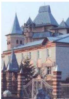
Здание частного санатория «Санус» в п. Кульдур (Кульдурский термоминеральный источник). 2005 г. ГАЕАО. Ф. Р-505. Оп. 5. Д. 1445.
