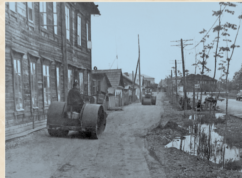
Укладка асфальта на улице Комсомоль- ской. 1961 год
