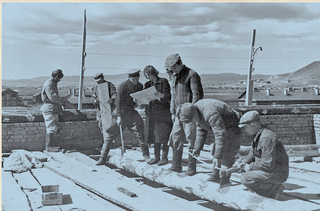
На строительстве жилых домов в Биробиджане
