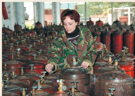
На эстакаде наполнительного цеха ГНС
