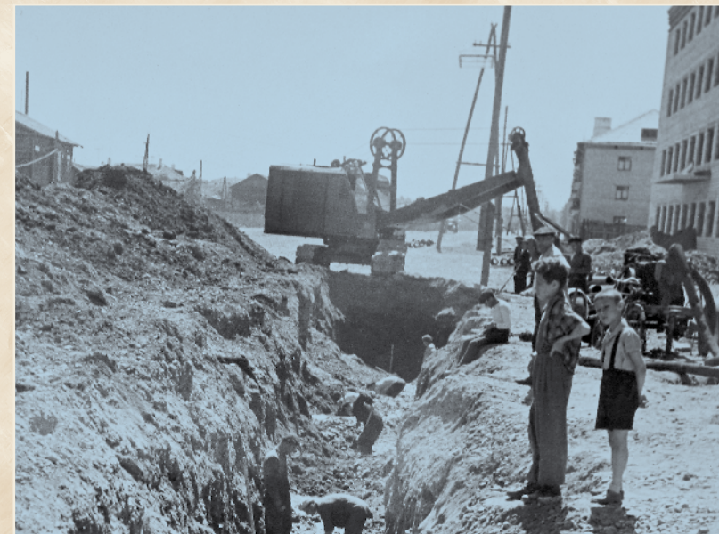
Прокладка водопровода в Биробиджане. 1961 год
