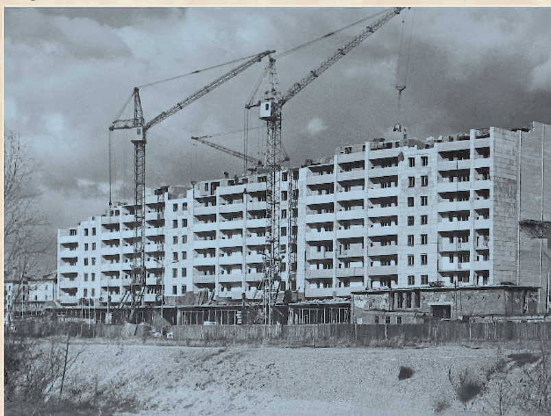
Строительство первого девяти- этажного дома в Биробиджане
