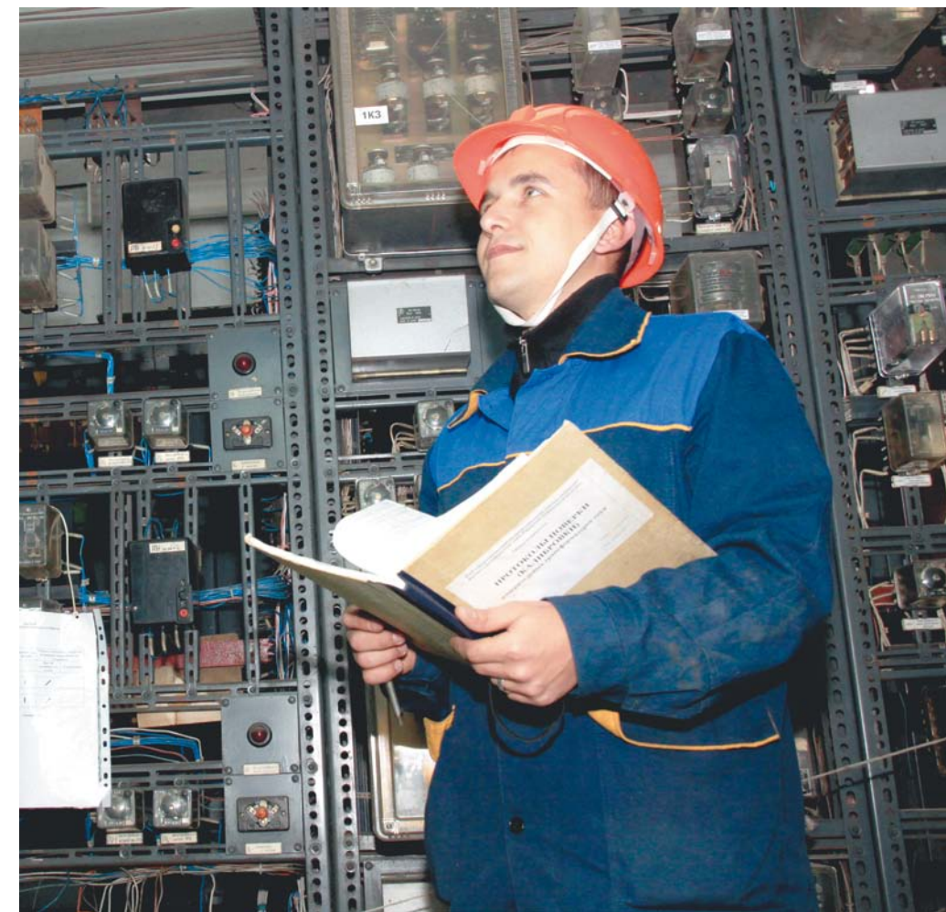
В оперативном управлении филиала ОАО «ДРСК» — «Электрические сети ЕАО» находятся более 40 подстанций напряжением 35–110 кВ
