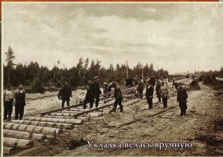
Работа монтеров пути
