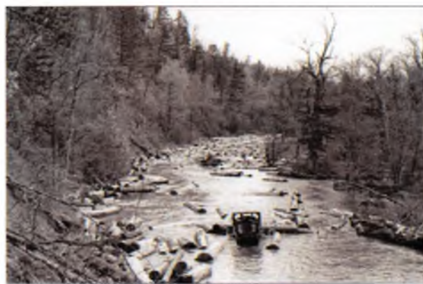
Бульдозер расстихивает завал на мелководье
