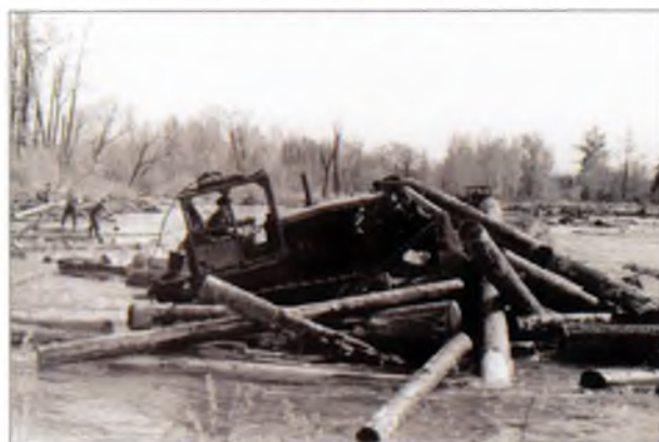
Бульдозер на разборке залома на р. Урми
