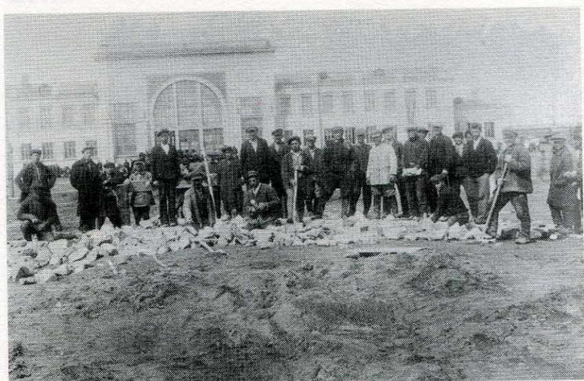
Pose des premiers pavés devant la gare de Birobidjan en 1936.
