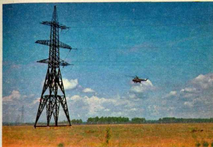
ЛЭП-500 — не простая линия
