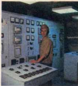
1—4. Теплоозерский цементный завод — передовое современное предприятие, оснащенное новейшим оборудованием. Здесь созданы все условия для труда и отдыха рабочих
